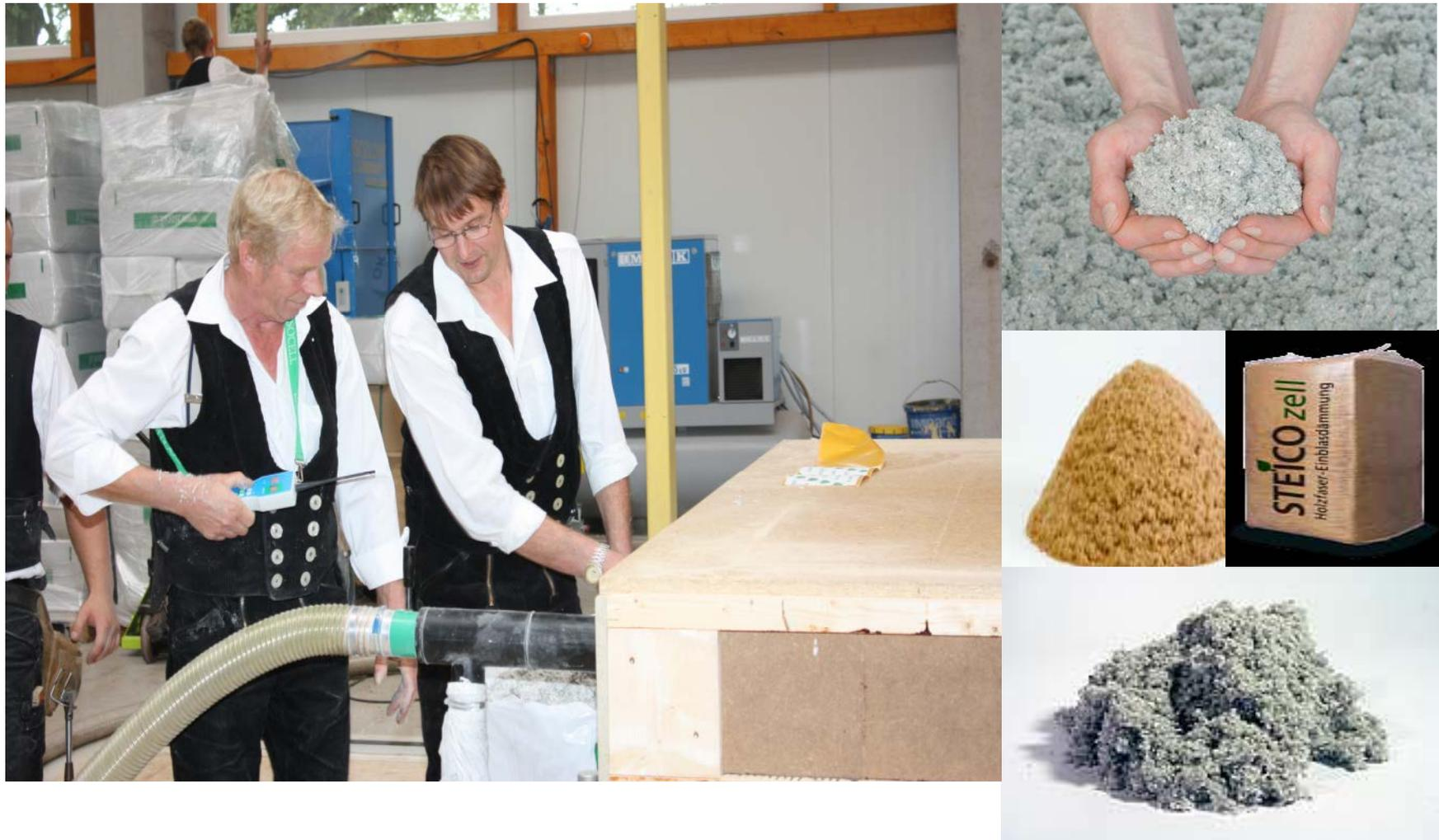
**Wärmedämmung mit Zellulosedämmung oder Holzfaserdämmung - das bedeutet Umweltschutz in vielerlei Hinsicht: geringster Energieverbrauch bei der Herstellung, nachwachsende Rohstoffe, sehr gute Wärmedämmung und Schalldämmung.**
